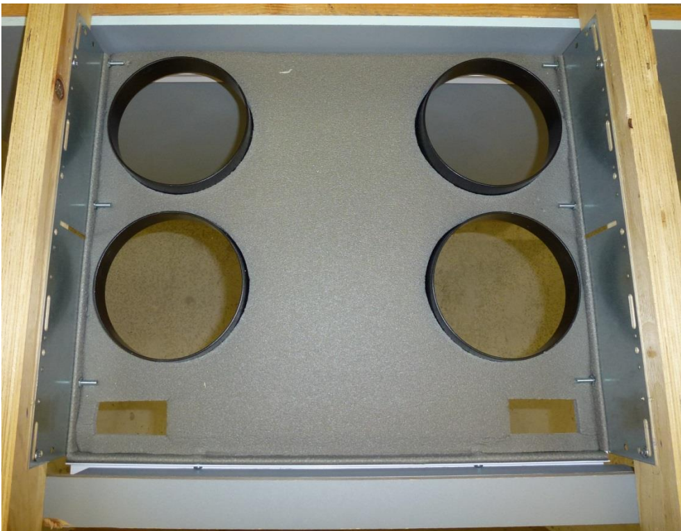
Kuva 1. Sivukiinnikkeiden asennus kattolevyyn ja ruoteisiin vaakaa-asennossa.
